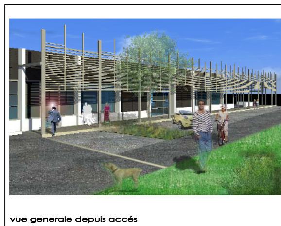
vue generale depuis accès
